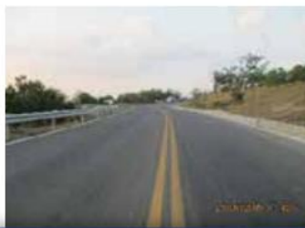
La Concesionaria realizó trabajos de mejoramiento de la estructura, construcción de cunetas e instalación de defensas metálicas en el PR 68, vía El Carmen de Bolívar - San Jacinto
