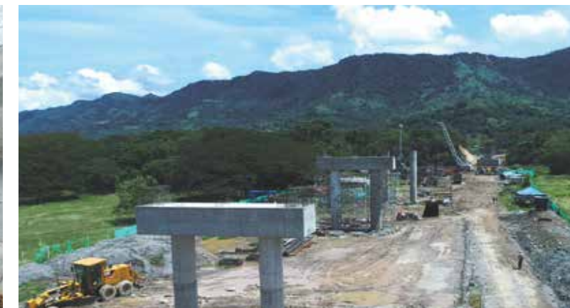
Girardot-Honda-Puerto Salgar Avanza construcción del nuevo puente de Puerto Salgar sobre el río Magdalena
