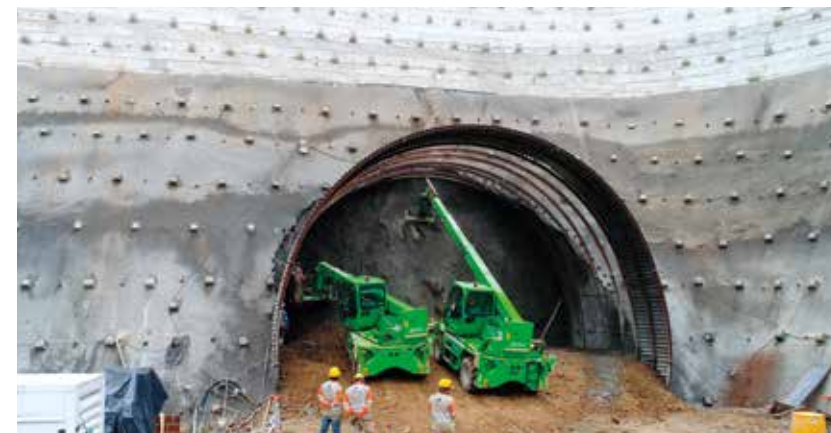
Autopista Conexión Pacífico 3 Continúan obras de construcción del Túnel de Tesalia
