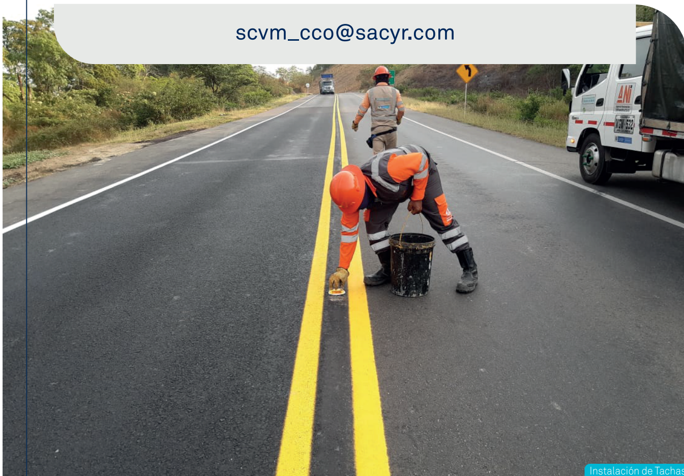
Instalación de Tachas
