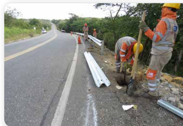
Actividades de instalación de defensas metálicas en el PR 72, Ruta 2515, El Carmen de Bolívar
