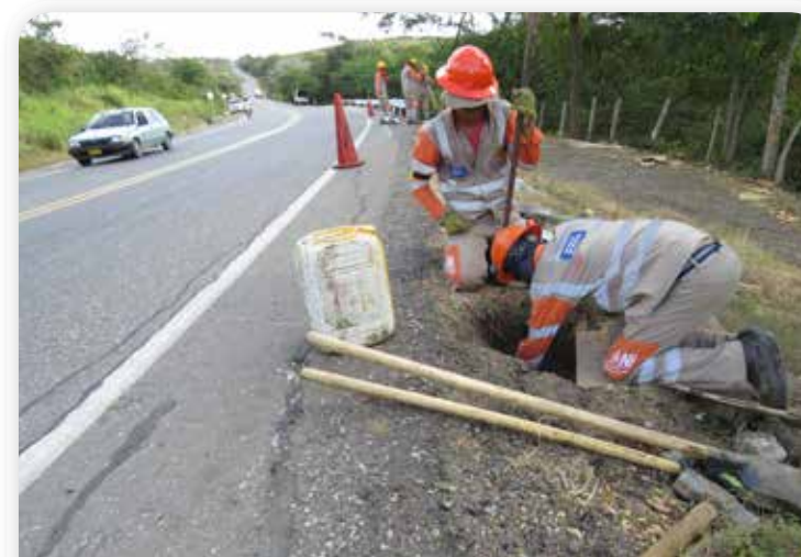
Actividades de instalación de defensas metálicas en el PR 72, Ruta 2515, El Carmen de Bolívar
