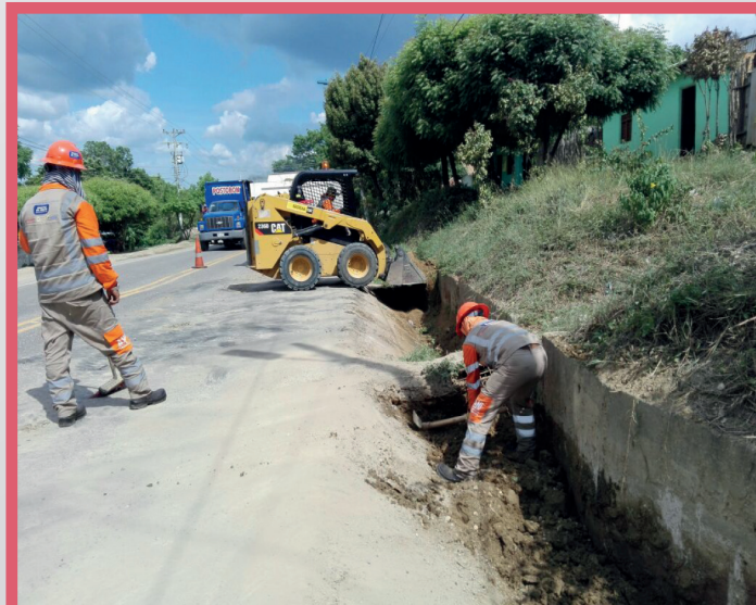
Limpieza de cuneta PR 66+250 RN 2515 El Carmen de Bolívar
