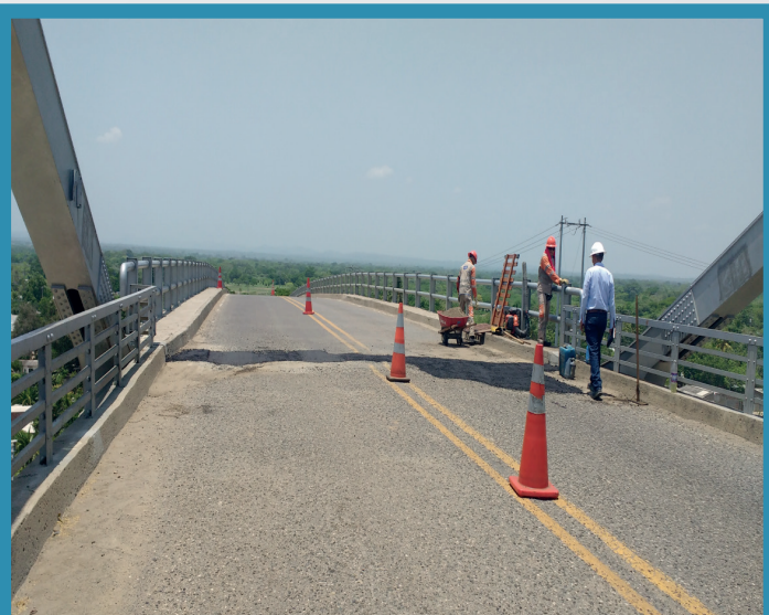
Parcheo Puente Calamar.UF3
