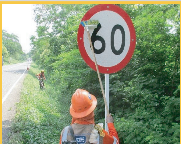
Limpieza de señales PR118+640 RN 2515
