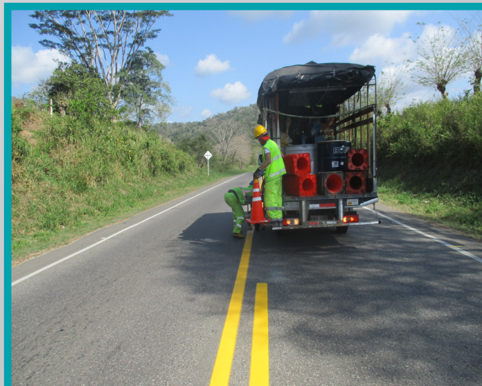
Demarcación vial PR 88+000 RN 2515
