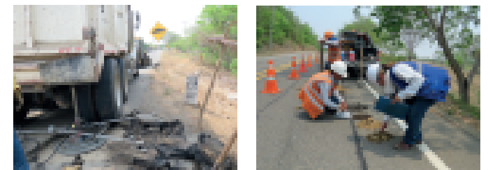
Pruebas de carga para conocer la capacidad de pavimento y estudios del suelo para determinar la estructura del mismo.
