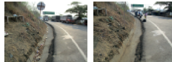
Actividades de limpieza de basuras al lado y lado del corredor vial -Vereda Carreto, municipio de San Juan Nepomuceno, Bolívar.
